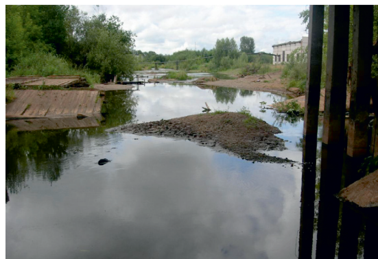
Рис. 7. Река Юг ниже автомобильного моста. В русле видны осередки
