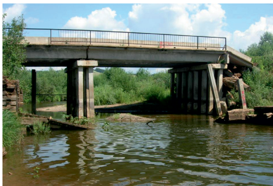
Рис. 6. Река Юг ниже автомобильного моста. Пропускная способность снижена из-за наличия в центральной части русла осередка, а у правого и левого берегов – остатков старого моста (вид снизу)
