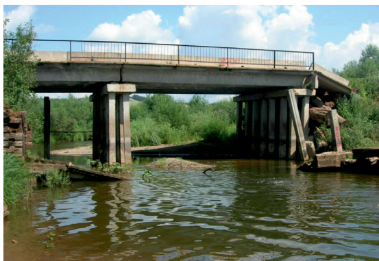
Рис. 6. Река Юг ниже автомобильного моста. Пропускная способность снижена из-за наличия в центральной части русла осередка, а у правого и левого берегов – остатков старого моста (вид снизу)
